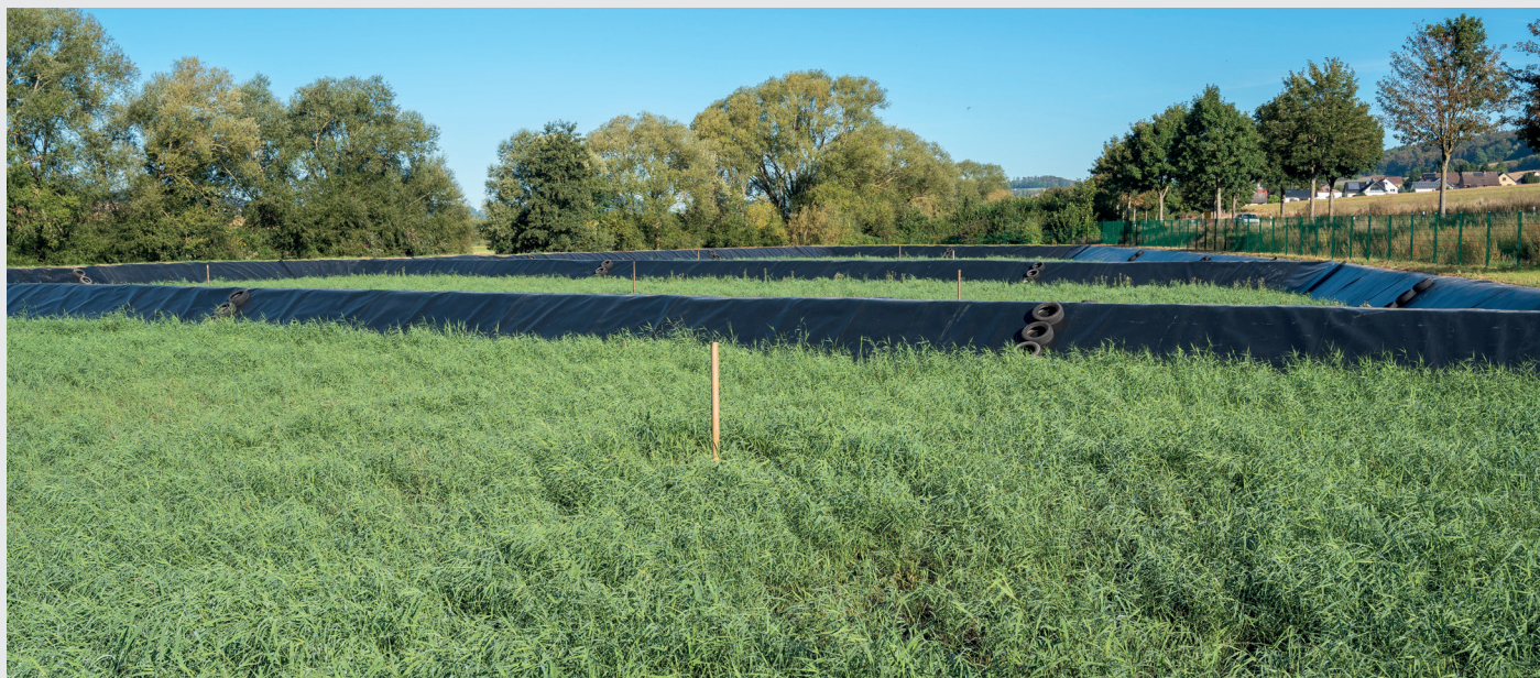
Bild 1 Die drei Schilfbeete der neuen Klärschlammvererdungsanlage Kalefeld entwässern und mineralisieren ab sofort 14.500 m 3 Nass-Schlamm pro Jahr.
